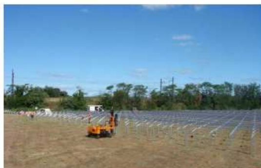
Battage des pieux
