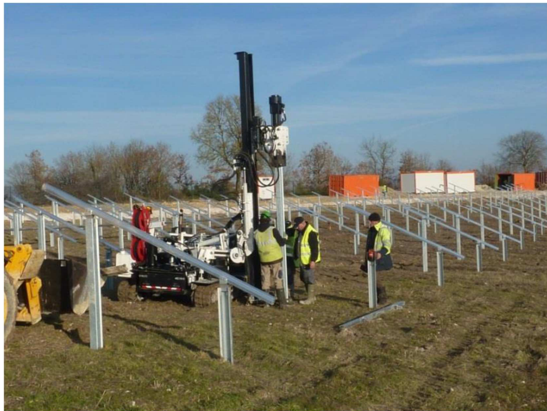
Figure 3 : Mise en place de support de panneaux
