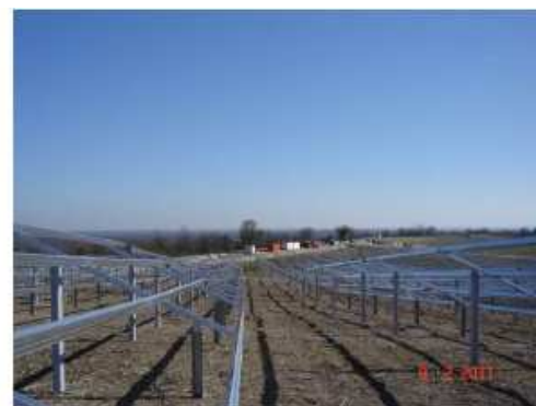
Fixation des rails de support
